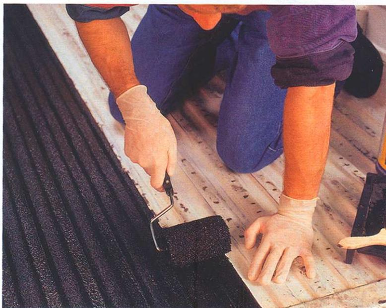
**Basta stendere con il rullo il rivestimento protettivo per ottenere più vantaggi: avere una superficie antiscivolo ed eliminare il rischio di ruggine**
